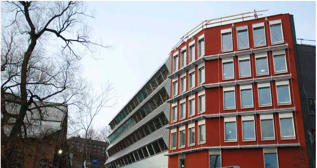
Den taggete fasaden er dekket av solfangere, som sørger for varmt vann til Bellonahuset og flere nabobygg. Foto: Ruth Astrid Sæter
