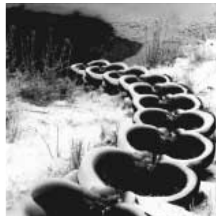
Vandtrapper, som indgår i vandrensningsanlæg
