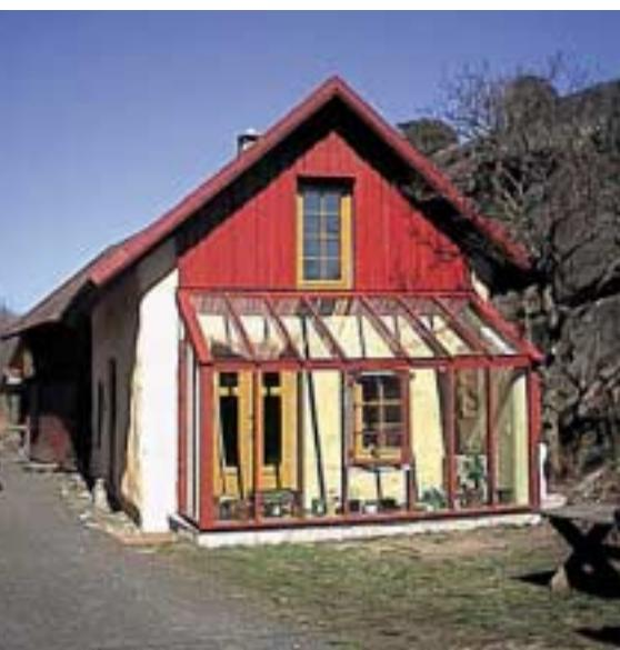
Kontor for Gaia Tjøme, som er oppført med halmvegger, leirepuss, ekte bindingsverkskonstruksjon og et isolert leiregolv.
