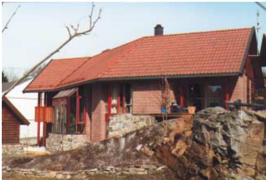
Bolig i Arendal med økologisk profil; skallmur i tegl isolert med perlite, naturlig ventilasjon og fleksibelt varmesystem med varmepumpe.
