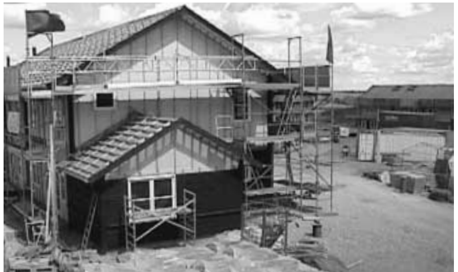
Munkesøgård - 20 økologiske huse ved Roskilde. Alt over jorden har Egen Vinding & Datter stået for. Der er papirisolering i alle elementer. Væggene er pressede lersten. Elementerne er af træ, gulvbrædderne genbrugsmaterialer. Vinduerne har Egen Vinding & Datter selv produceret.
