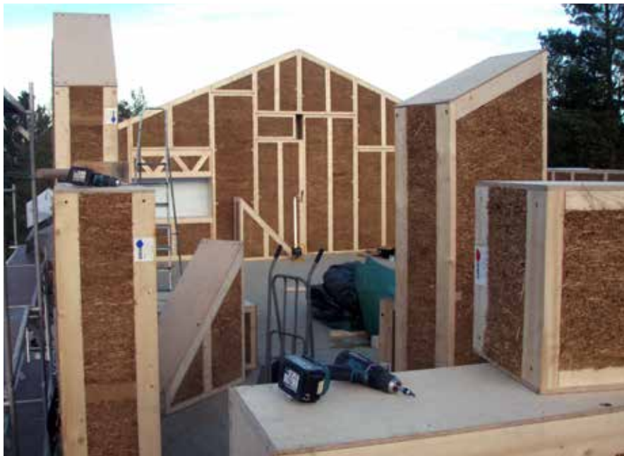
Halm-element bygg under oppføring.
