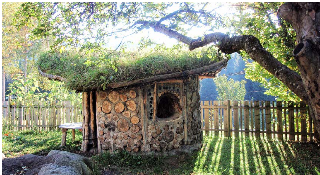
Lekehus oppført med vegger av innmurte vedkubber. Stolpe/stokkehus bygget av 4. klasse med hjelp av eldre elever ved Steinerskolen i Hurum.
