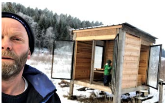
Mikrohus basert på slippliftsystem. Yttermål grunnflate 290 cm x 290 cm. Veggelementer fra AV3 er produsert med en fres som følger trestokkens naturlige form og har samme estetiske uttrykk som håndlaft. Enkelt å montere og demontere. Minimalt fotavtrykk i naturen.
