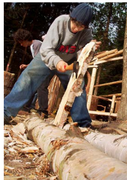
Videregåendelev hugger til planker ut av en gedigen stokk. De skal bli til dør i et lekehus bygget på oppdrag fra en offentlig barnehage. 3. videregående trinn tjente slik en god slant til klasseturen sin.
