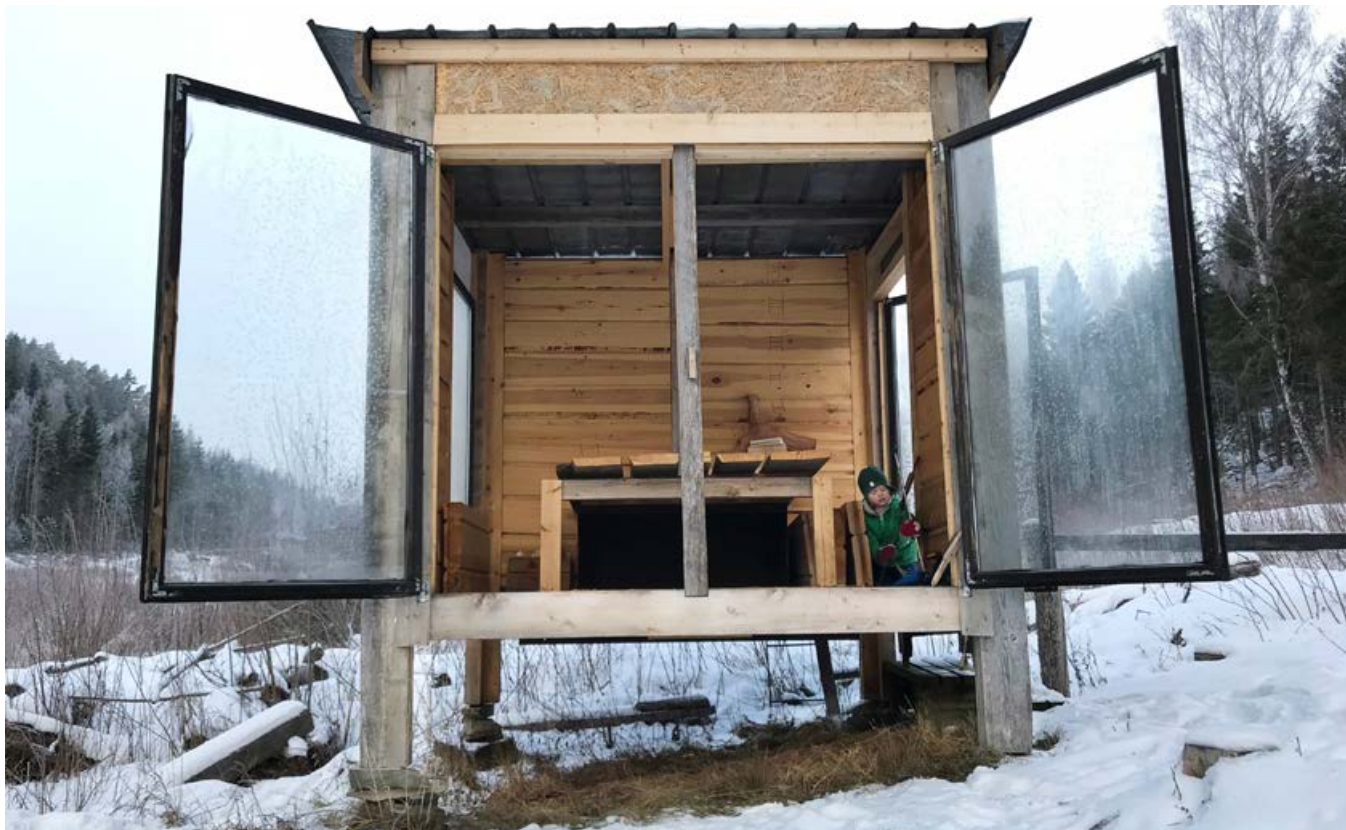
Prototype er utviklet utelukkende med gjenbruksmaterialer. Rammeverk er gjenbruk av materialer fra flytende kunstinstallasjon på Mjøsa. Tømmerveggene er utsparinger til dører og vinduer fra AV3s produksjon. Dører fra Tøyen senter og tak Sankt Halvardsgate i Oslo. Mikrohuset i bildet er tiltenkt en funksjon som frittstående anneks til bruk i sommerhalvåret. Moduler kan settes sammen til konstruksjon med større grunnflate og rom med ulike funksjoner.
