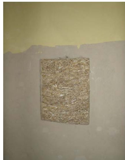
Innvendig avsluttes med leirmørtel pusset direkte på halmen og fargelagt med leirmaling.
