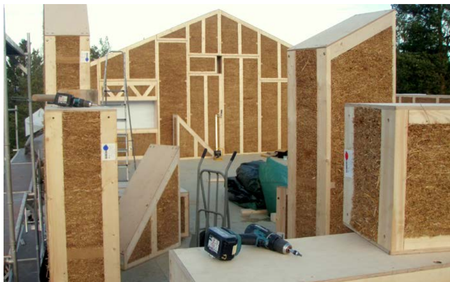
Halmelementer leveres som byggeklosser og samles enkelt ved hjelp av skruer og drill.
