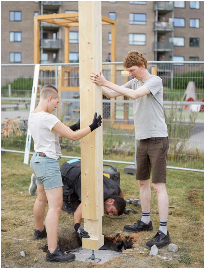
Ina Hagen (til venstre), snekker Alexander Salim (midten) og Steffen Håndlykken (til høyre) på byggeplass.
